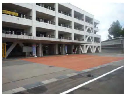
瓦リサイクルの施工例(庄内総合支庁正面)
