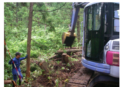
根株を盛土補強材として配置
