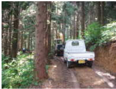
丁寧に締め固めれば車両進入も可
