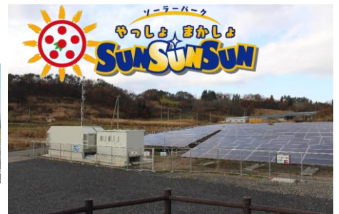
太陽光発電事業施設
