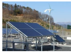
両面太陽光発電 小型風力発電
